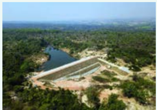
โครงการอ่างเก็บน้ำชำตมขาวอันเนื่องมาจากพระราชดำรินี้
